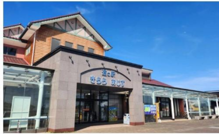
道の駅きららあじす
